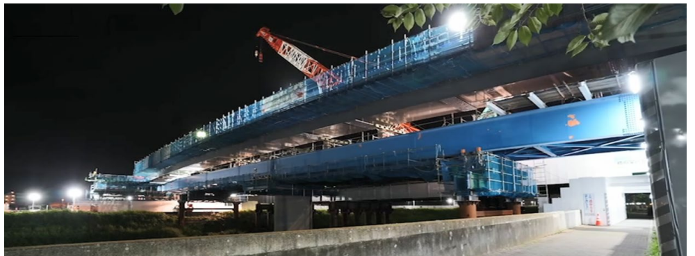
▲既存通行橋の更新工事の様子 無橋脚で流域阻害の無い78mロングスパンの橋を既存橋の上で建設し 一晩で新設場所まで10mスライド
