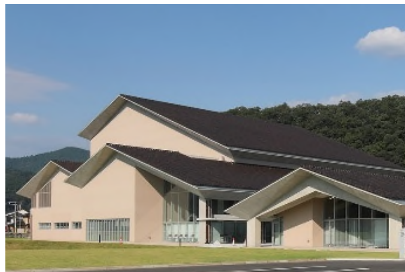
■ 完成した屋根シルエット
