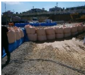
土嚢による流出対策
