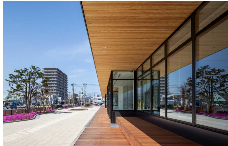
小間屋テラス
