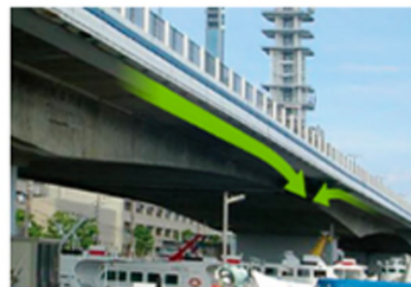
中央部の垂れ下がりが進行する橋桁
