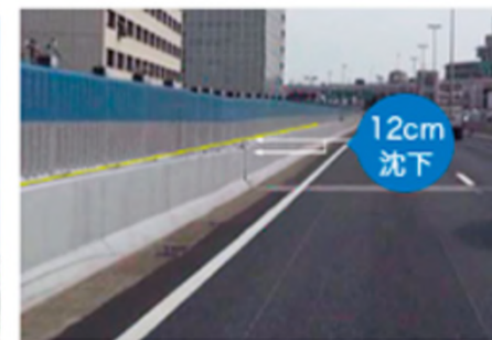
橋桁の中央付近が設計時の想定よりも大きく沈下
