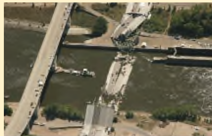
米・ミシシッピ川の高速度道路橋の落橋 (2007年) (出典: MN/DOT)
