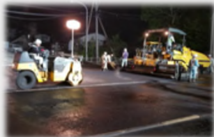
通行不能の交差点での応急工事
