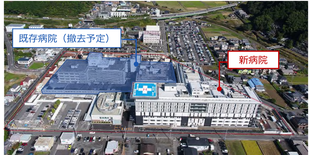
2021年10月撮影（表記無き限り、写真は島田市立総合医療センターHPより） 左奥が旧島田市民病院（撤去予定）、右手前が新病院（島田市立総合医療センター）。 既存病院敷地内での近接施工であり、施工期間中の医療行為の継続が重要となった。
