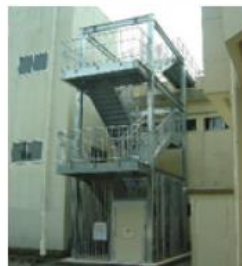
改修事例(外階段の設置)
