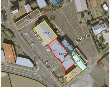
鞍手町役場（旧庁舎）の建物構成と外観
