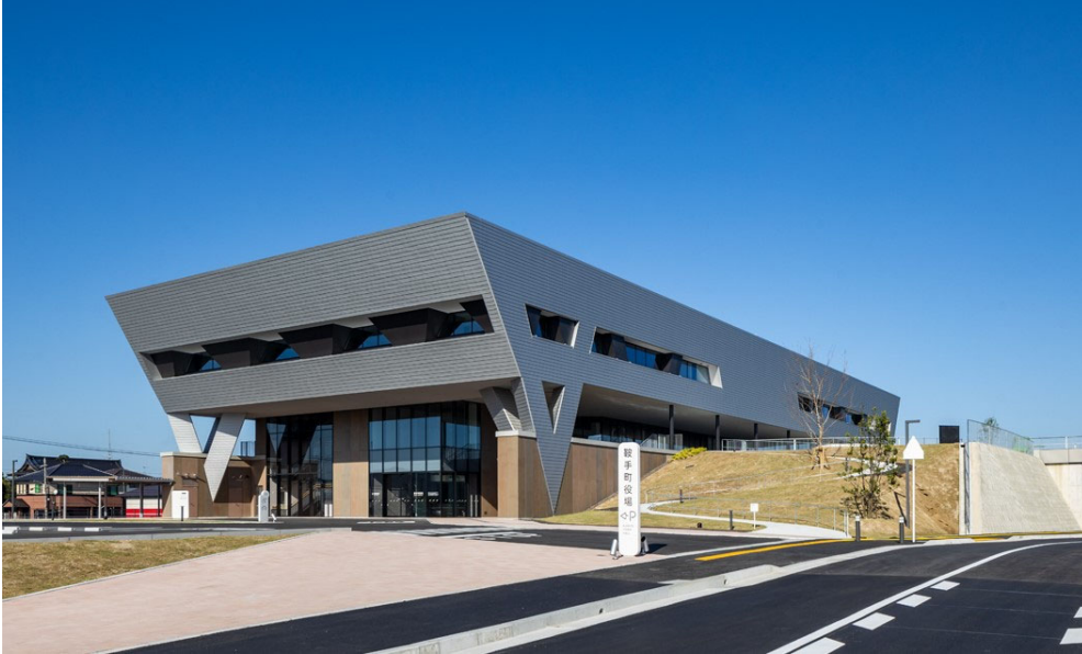
鞍手町役場（新庁舎）
