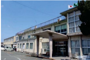
鞍手町役場（旧庁舎）
