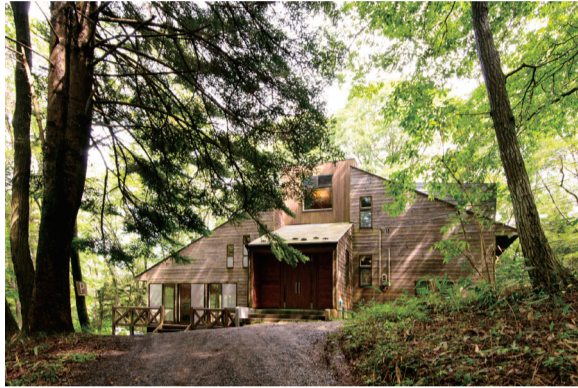
宿泊棟（西側外観）／Ⅱ期工事
