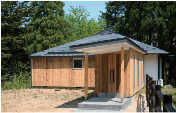
礼拝堂（南側外観）／Ⅰ期工事
