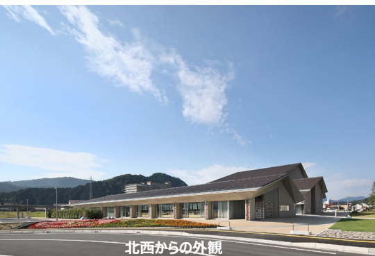
北西からの外観
